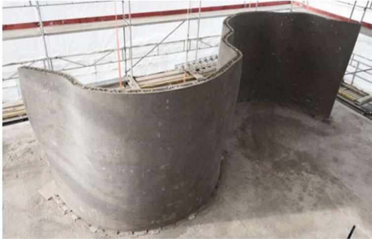
*Figure I. 9 - DFAB « Mesh mould wall », mur obtenu par « Mesh mould » par Hack et al. [93].*
