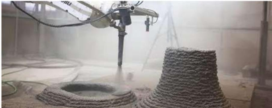
*Figure I. 4 - Shortcrete 3D printed structure (d'après Kristombu Baduge et al.[61]).*
