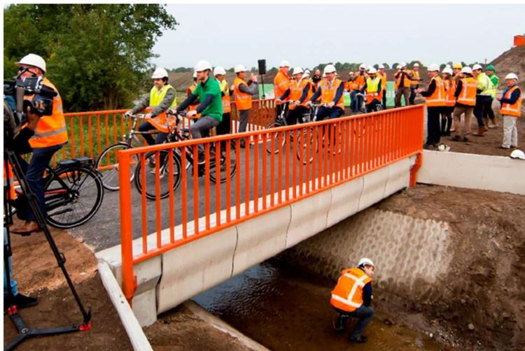
*Figure I. 10 - Pont pour vélo imprimé par 3D Concrete printer de Salet et al. [27].*
