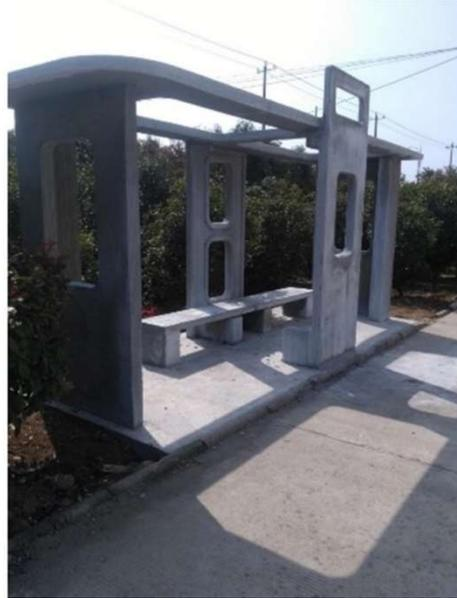
*Figure I. 11 - Abris bus imprimée par Zhang et al. [98].*
